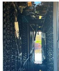
Compte-tenu de l'importance de la consommation d'eau utilisée pour le refroidissement, plusieurs options sont envisagées (démontage/immersion des batteries endommagées, noyage du container impacté, refroidissement des points chauds à l'aide d'extincteurs CO2). Seule la dernière option a été tentée et s'est avérée d'une efficacité très limitée.
